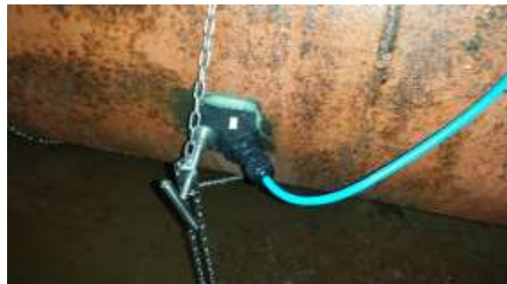
MONTAJE DE SENSOR
