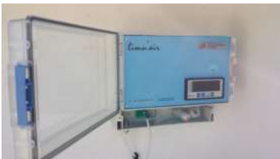
MEDIDA DE NIVEL POR BURBUJEO
